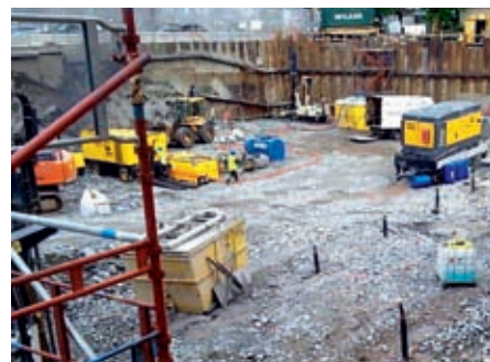
Här borras 70 hål för värme mitt i stan.
